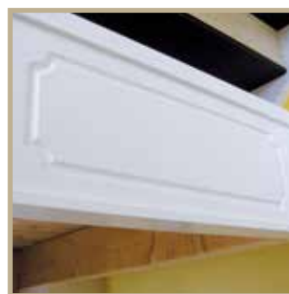
Deckenverkleidung eingefräste Kasette
